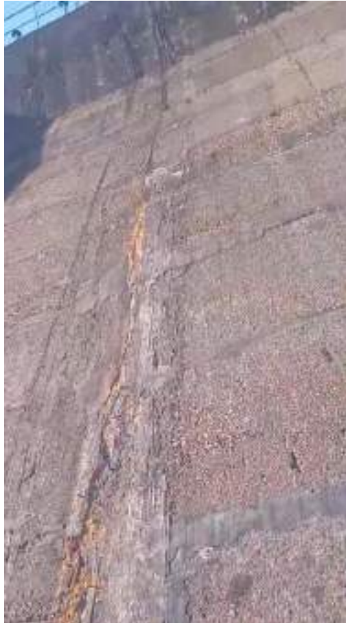
Figura 132 – Injeção de poliuretano na VAC 04.
