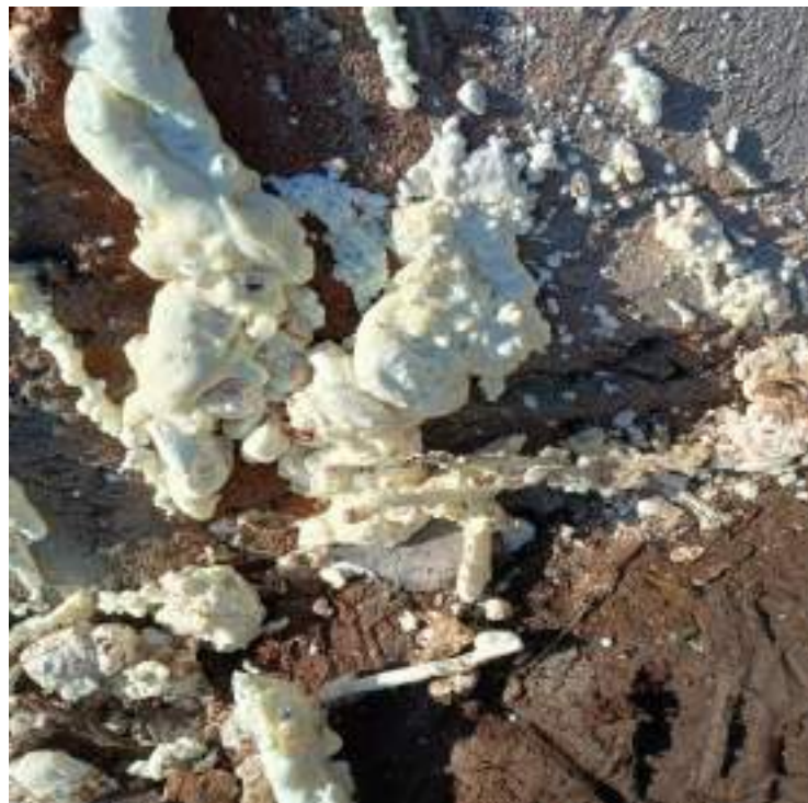
Figura 123 – Injeção de poliuretano na VAC 04.
