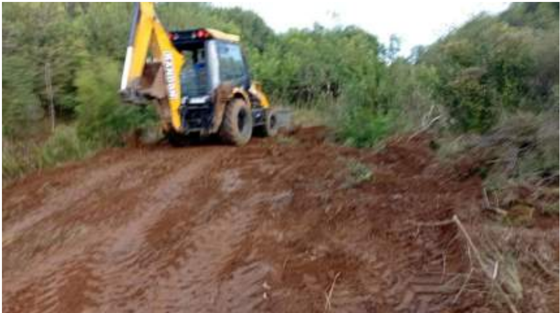
Figura 24 – Atividade de reconstrução do aterro no Canal VAC 04.
