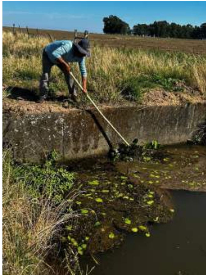
Figura 161 – Atividades de manutenção.
