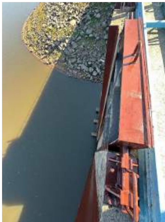
Figura 137 – Manutenção no sistema VAC 04.
