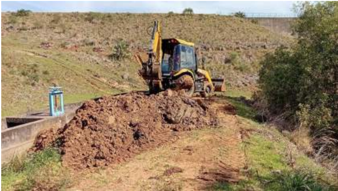
Figura 52 – Atividades de reparo.
