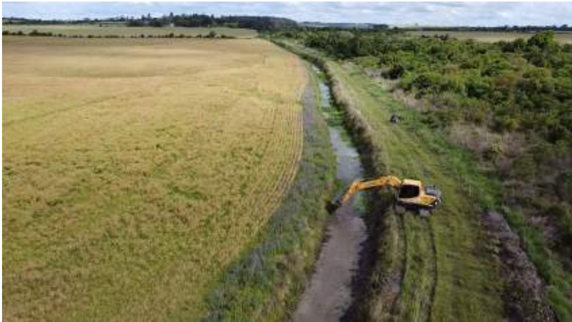
Figura 80 – Atividades de limpeza VAC 07.
