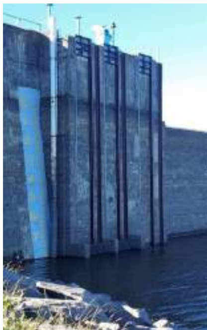
Figura 135 – Manutenção no sistema VAC 04.
