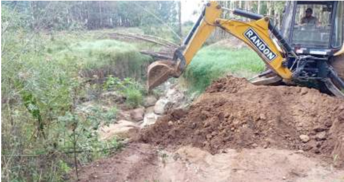
Figura 2 – Atividade de reconstrução da borda do canal.
