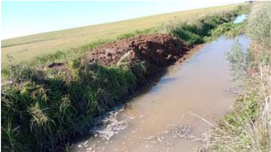
Figura 70 – Atividades de reparo.
