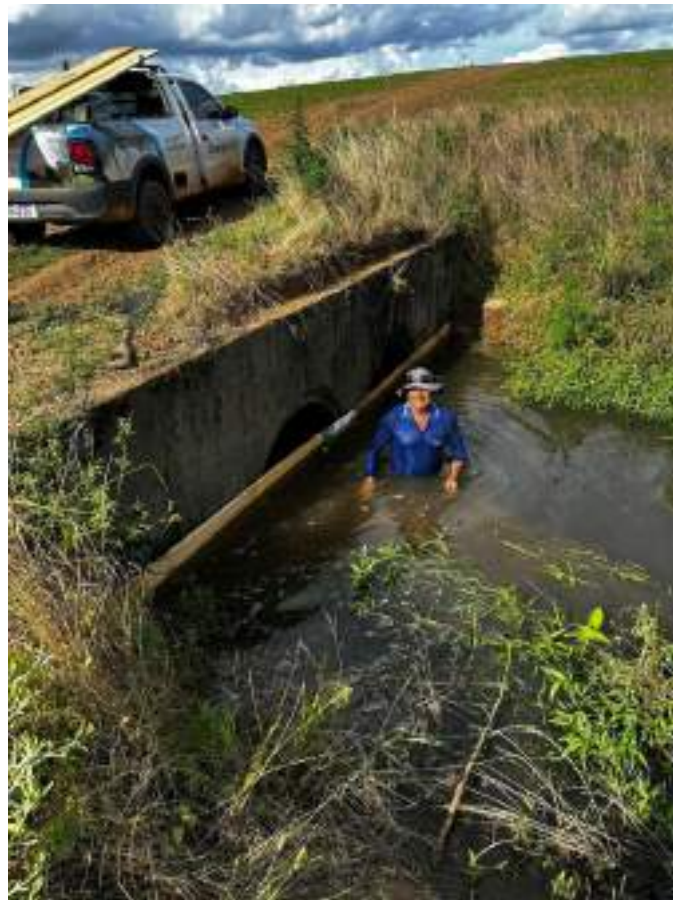
Figura 163 – Atividade de manutenção.
