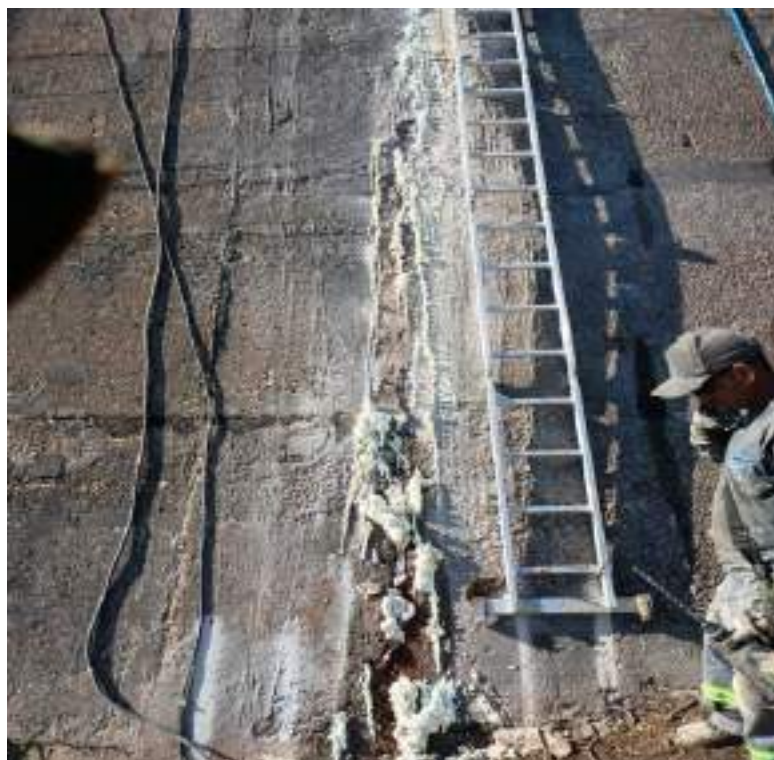
Figura 125 – Injeção de poliuretano na VAC 04.
