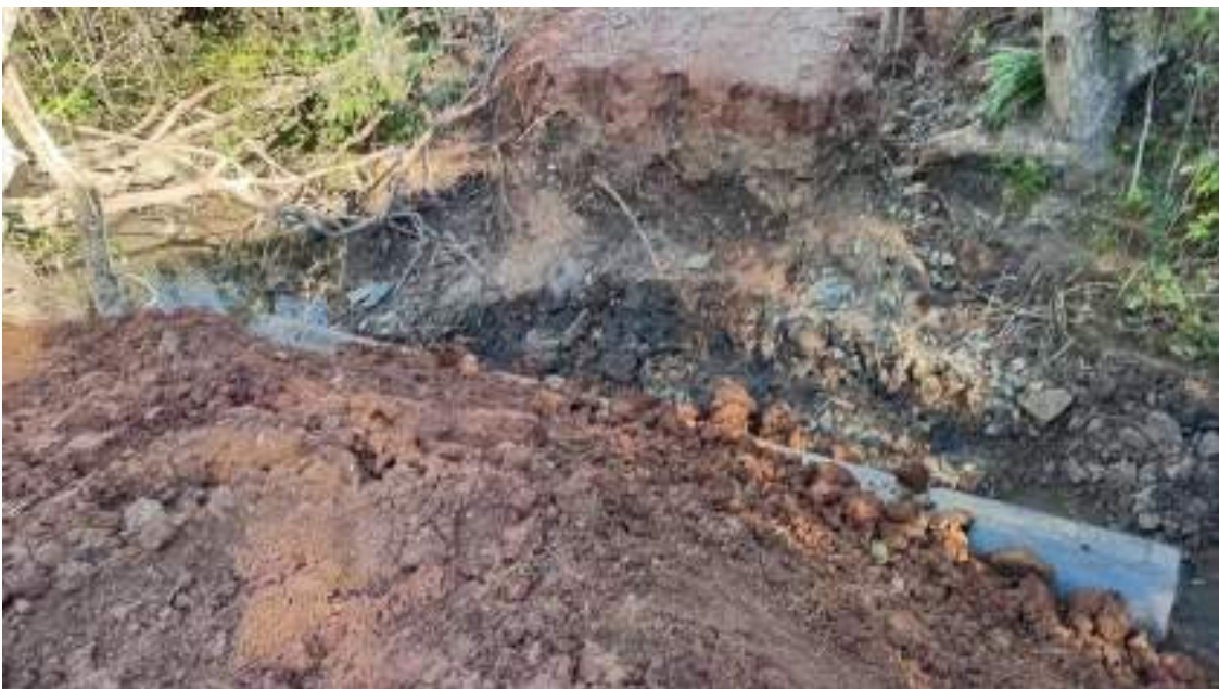
Figura 57 – Atividades de reparo.
