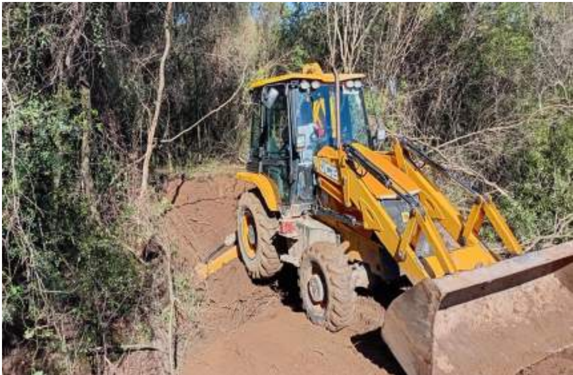
Figura 59 – Atividades de reparo.
