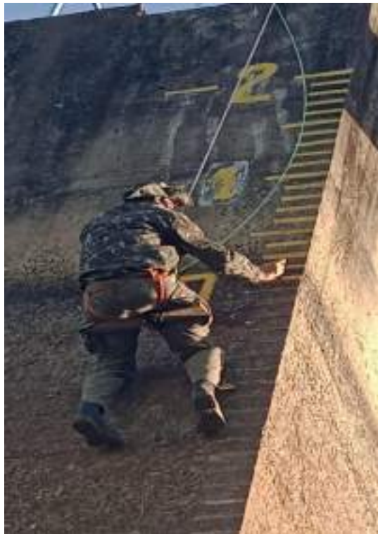
Figura 141 – Manutenção no sistema VAC 06.
