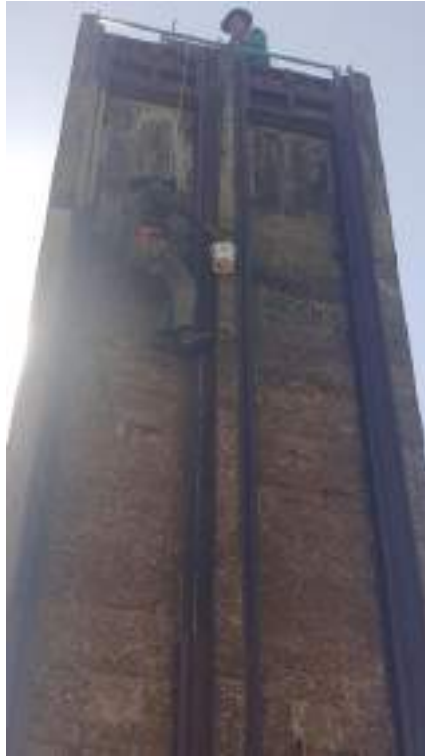
Figura 142 – Manutenção no sistema VAC 06.
