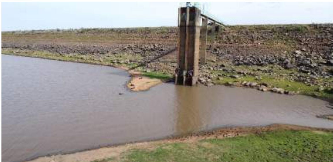
Figura 139 – Manutenção no sistema VAC 06.
