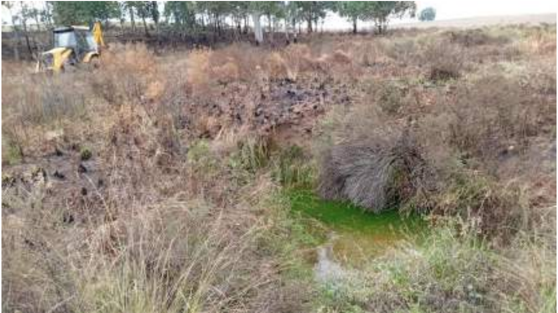
Figura 6 – Atividade de limpeza.
