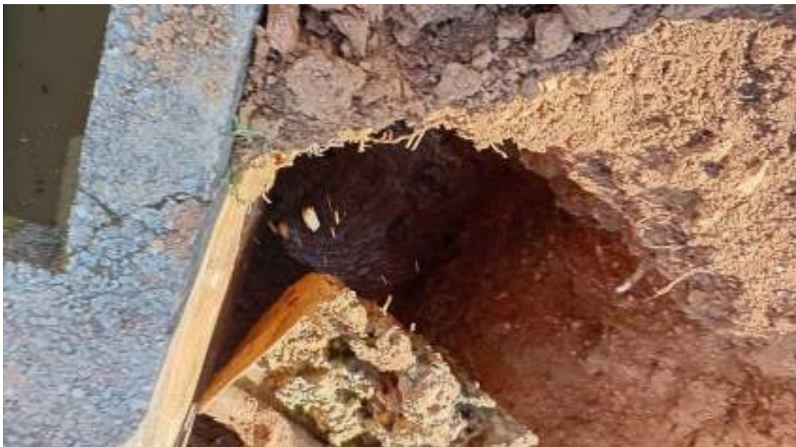
Figura 113 - Atividade de reparo no Canal VAC 04.
