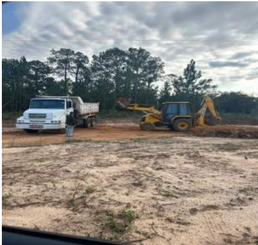
Figura 22 – Atividade de reconstrução do aterro no Canal VAC 04.
