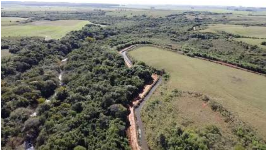
Figura 100 – Atividades de limpeza VAC 04.
