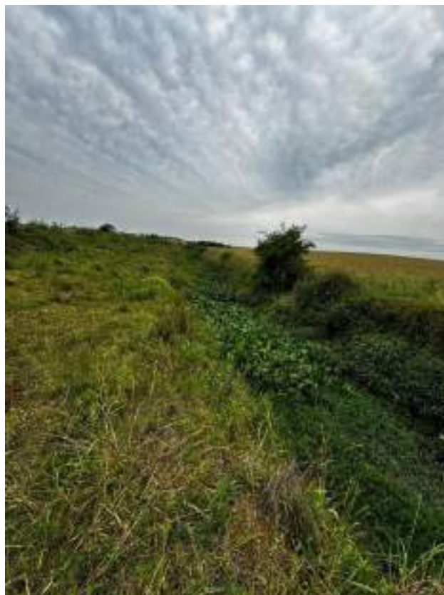
Figura 87 – Atividades de limpeza VAC 07.
