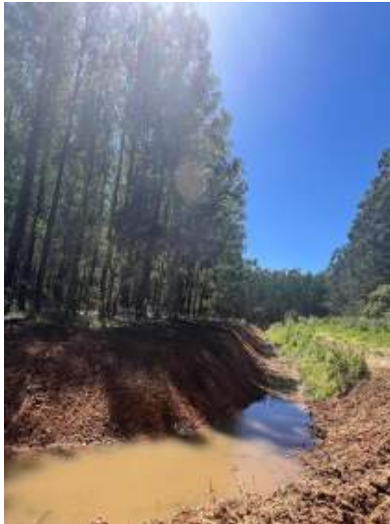
Figura 112 – Finalização da atividade de remoção dos eucaliptos na VAC 04.
