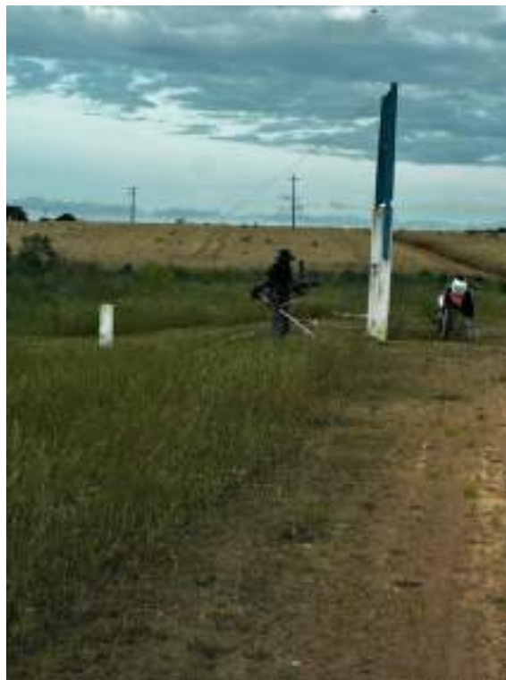
Figura 154 – Atividade de manutenção.
