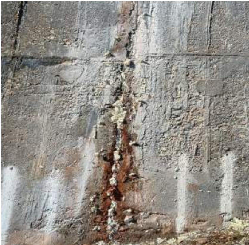
Figura 124 – Injeção de poliuretano na VAC 04.
