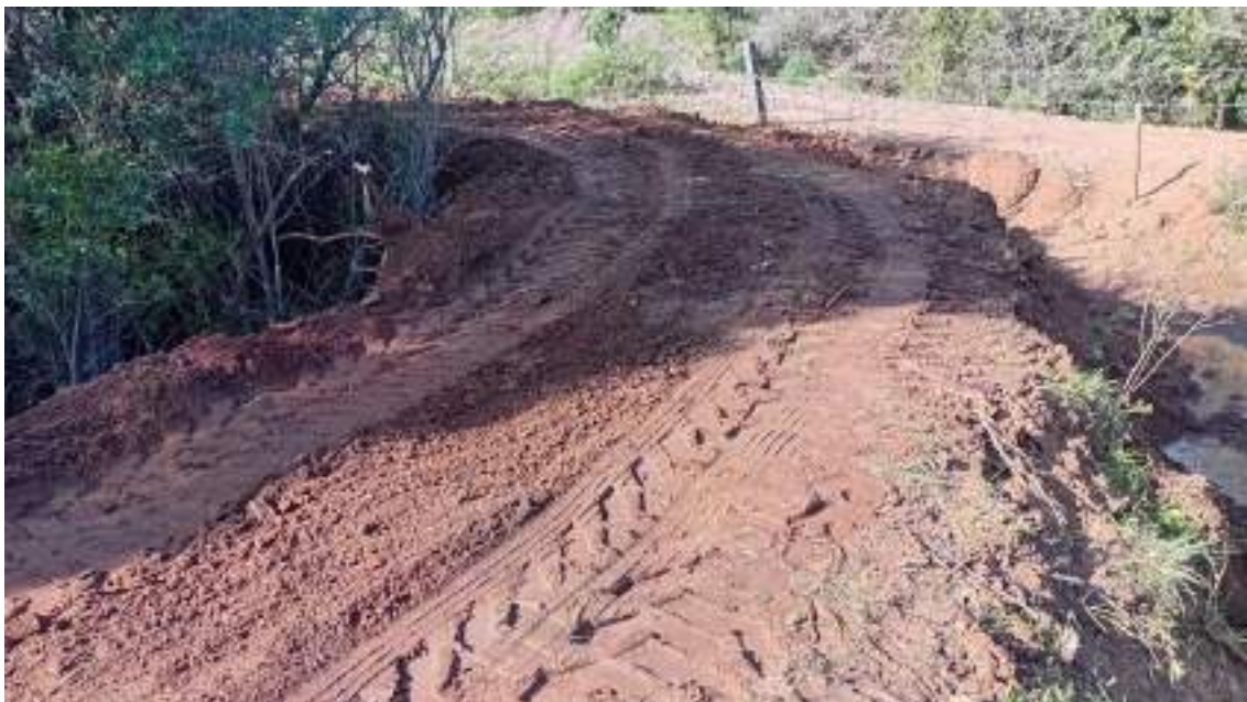
Figura 61 – Atividades de reparo.
