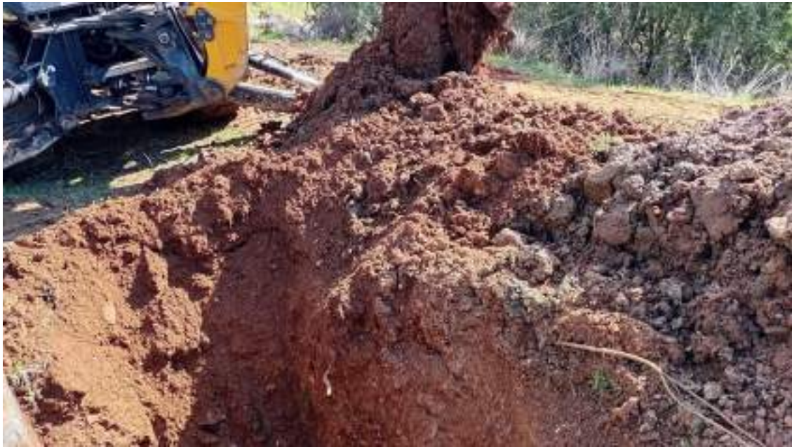
Figura 114 - Atividade de reparo no Canal VAC 04.
