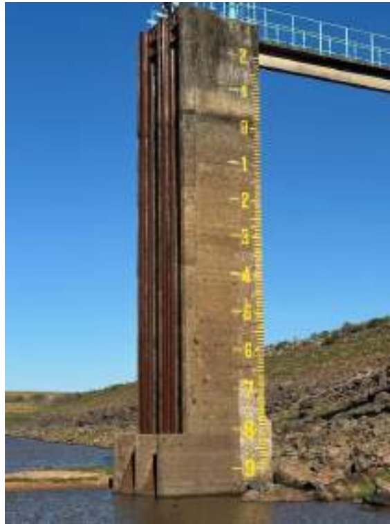
Figura 144 – Manutenção no sistema VAC 06.
