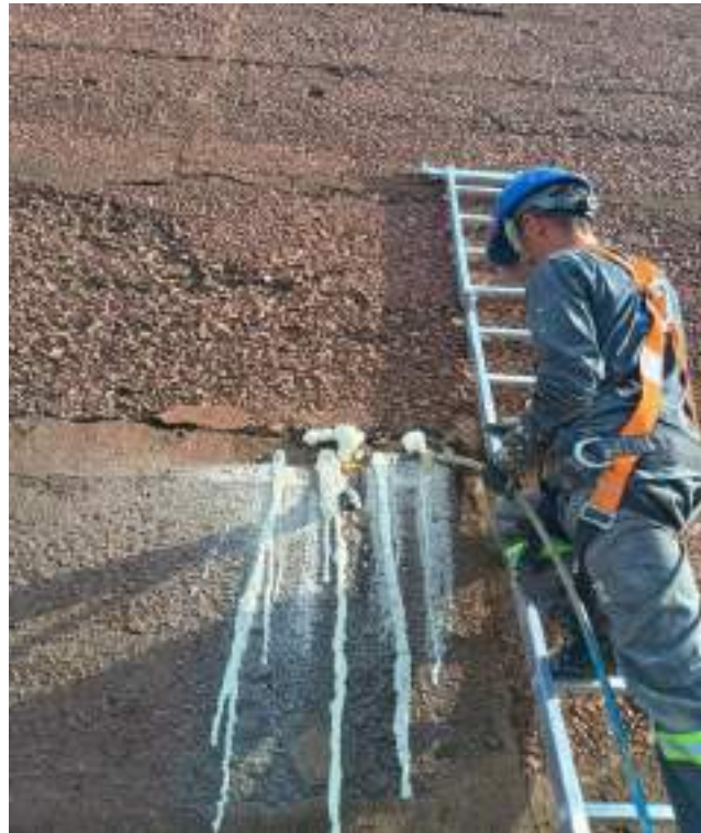
Figura 126 – Injeção de poliuretano na VAC 04.
