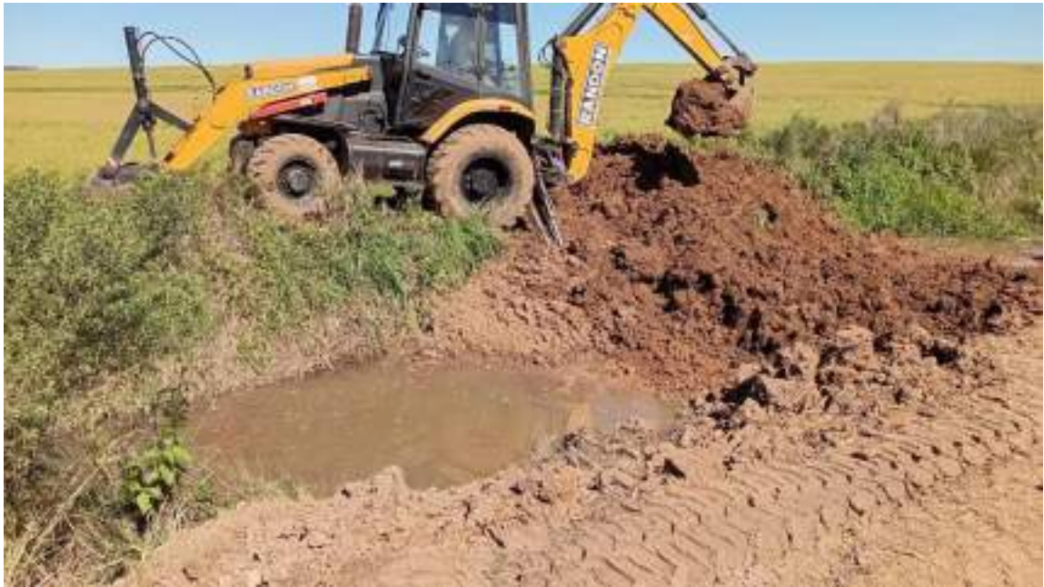
Figura 66 – Atividades de reparo.
