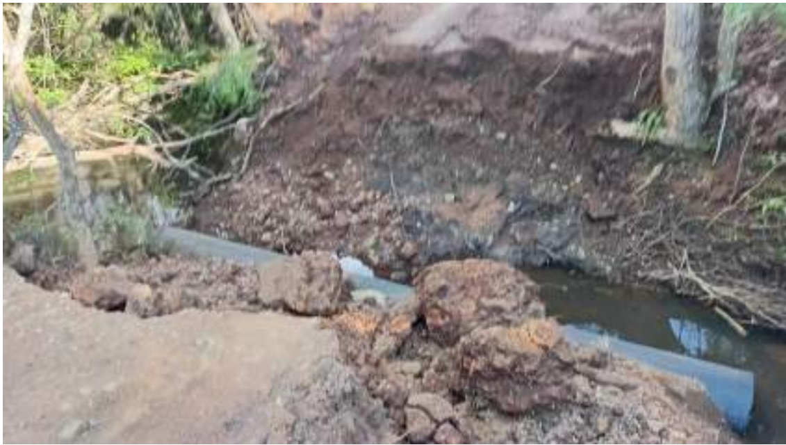
Figura 56 – Atividades de reparo.
