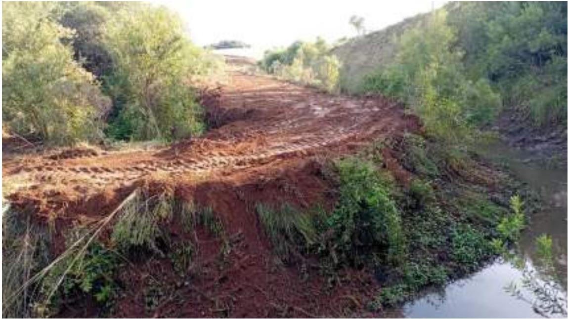
Figura 12 – Atividade de limpeza
