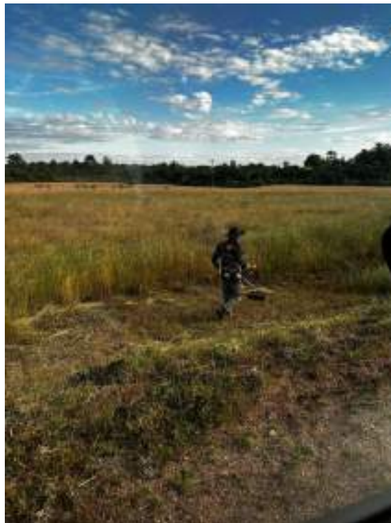
Figura 216 – Limpeza do Canal VAC 07.
