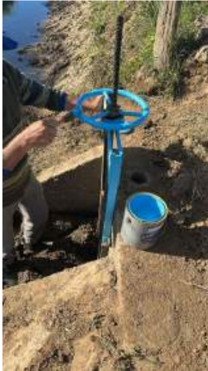
Figura 153 – Atividade de manutenção.
