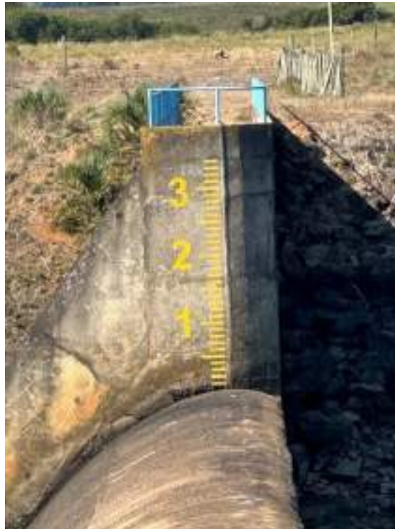
Figura 136 – Manutenção no sistema VAC 04.
