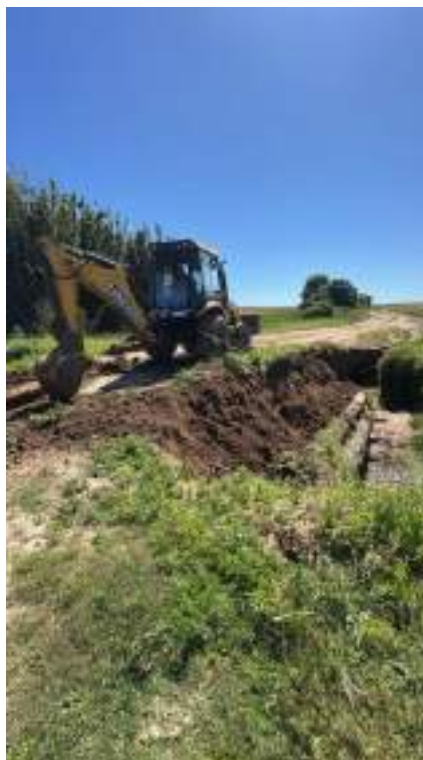
Figura 63 – Atividades de reparo.
