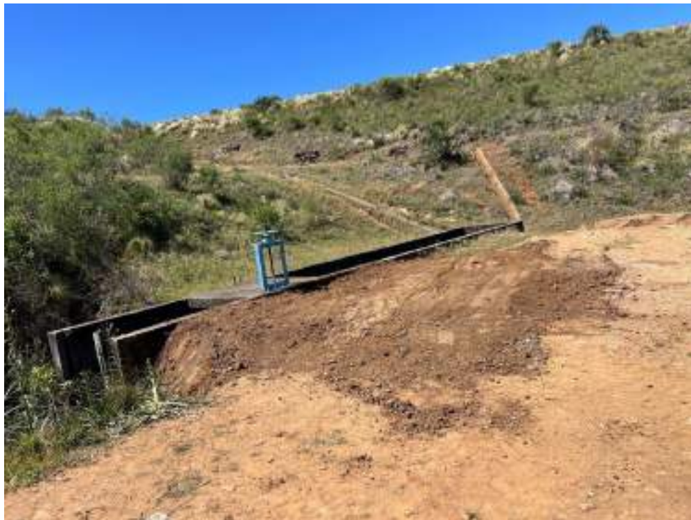
Figura 117 - Atividade de reparo no Canal VAC 04.
