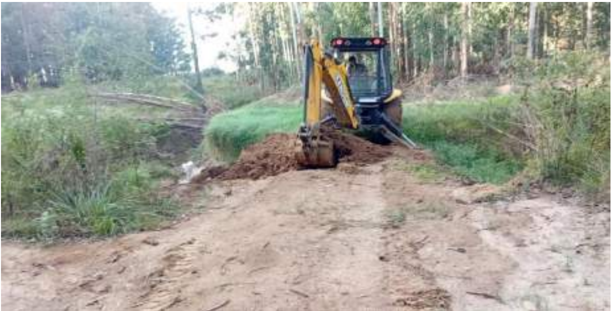
Figura 3 – Atividade de reconstrução da borda do canal.
