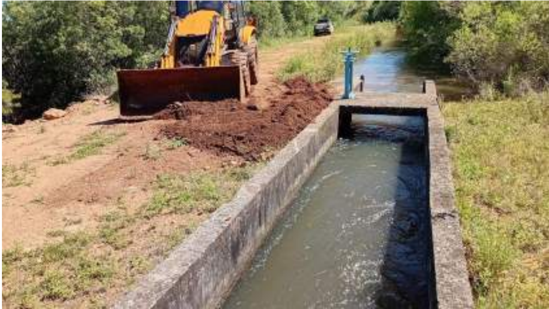
Figura 116 - Atividade de reparo no Canal VAC 04.
