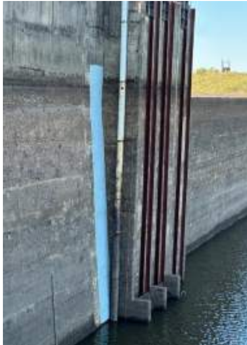
Figura 134 – Manutenção no sistema VAC 04.
