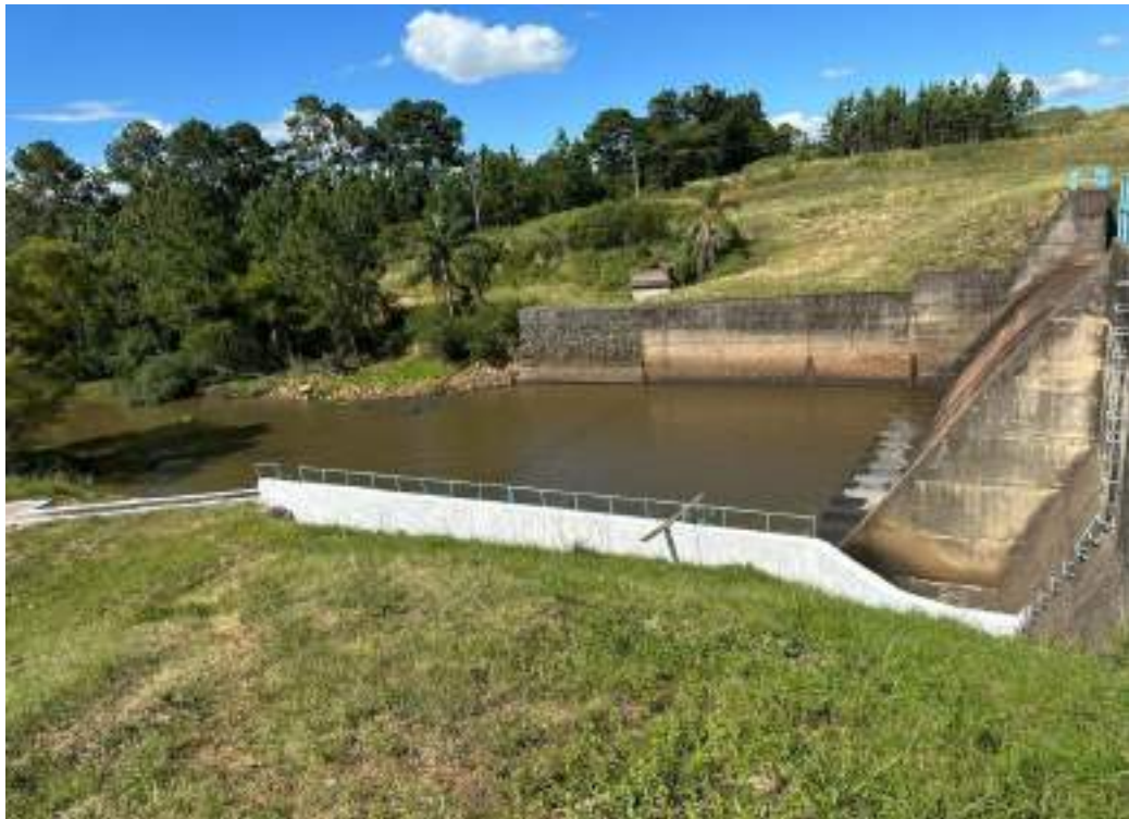
Figura 215 – Limpeza do Canal VAC 07.
