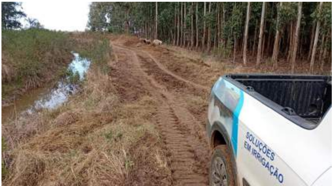
Figura 41 – Atividade de limpeza.
