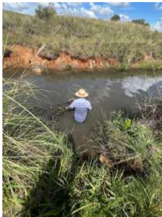
Figura 166 – Atividade de manutenção.
