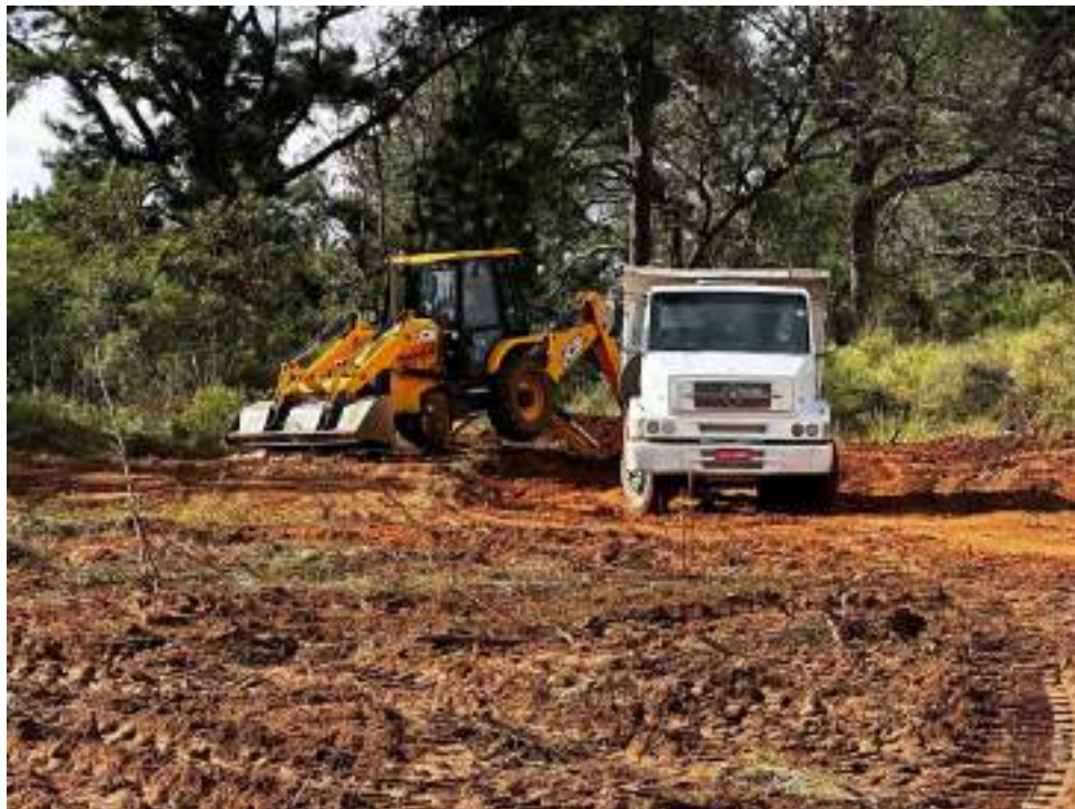
Figura 23 – Atividade de reconstrução do aterro no Canal VAC 04.
