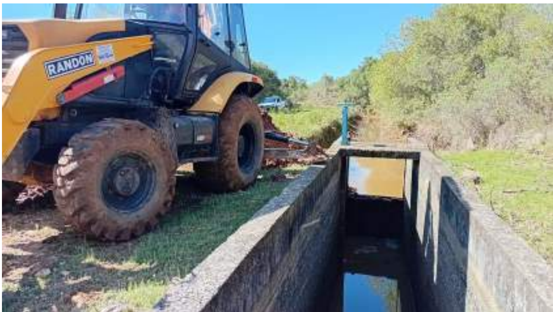
Figura 53 – Atividades de reparo.
