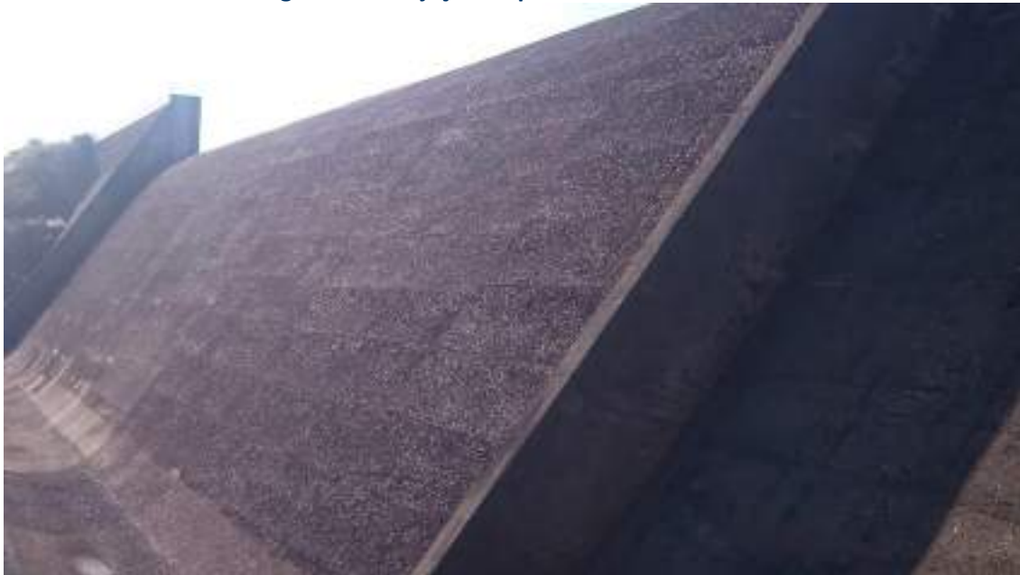
Figura 131 – Injeção de poliuretano na VAC 04.
