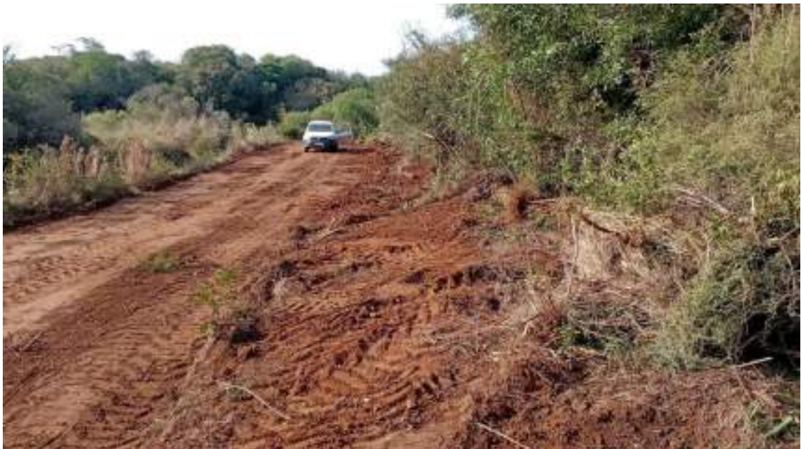
Figura 25 – Atividade de reconstrução do aterro no Canal VAC 04.
