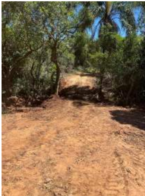
Figura 119 - Atividade de reparo no Canal VAC 04.
