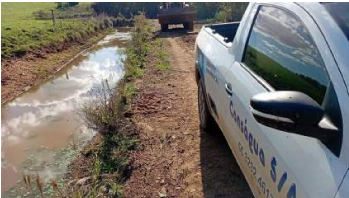
Figura 55 – Atividades de reparo.
