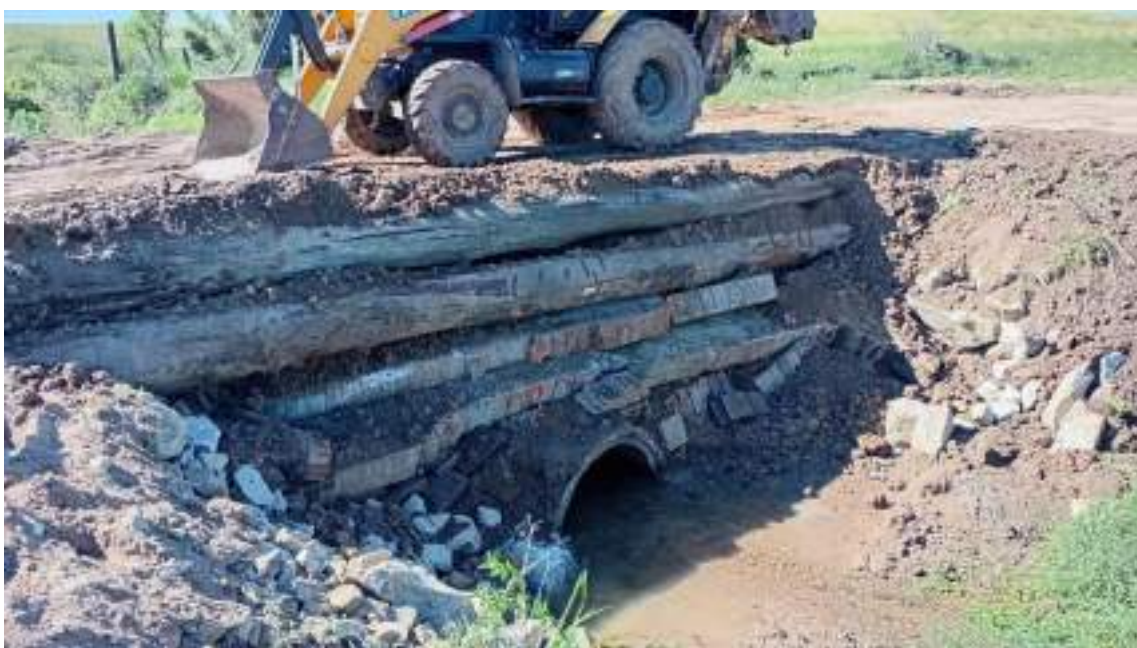
Figura 65 – Atividades de reparo.
