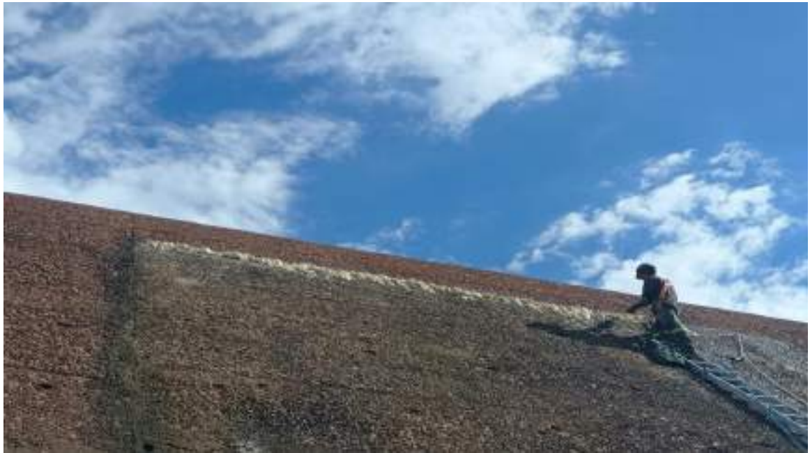
Figura 122 – Injeção de poliuretano na VAC 04.
