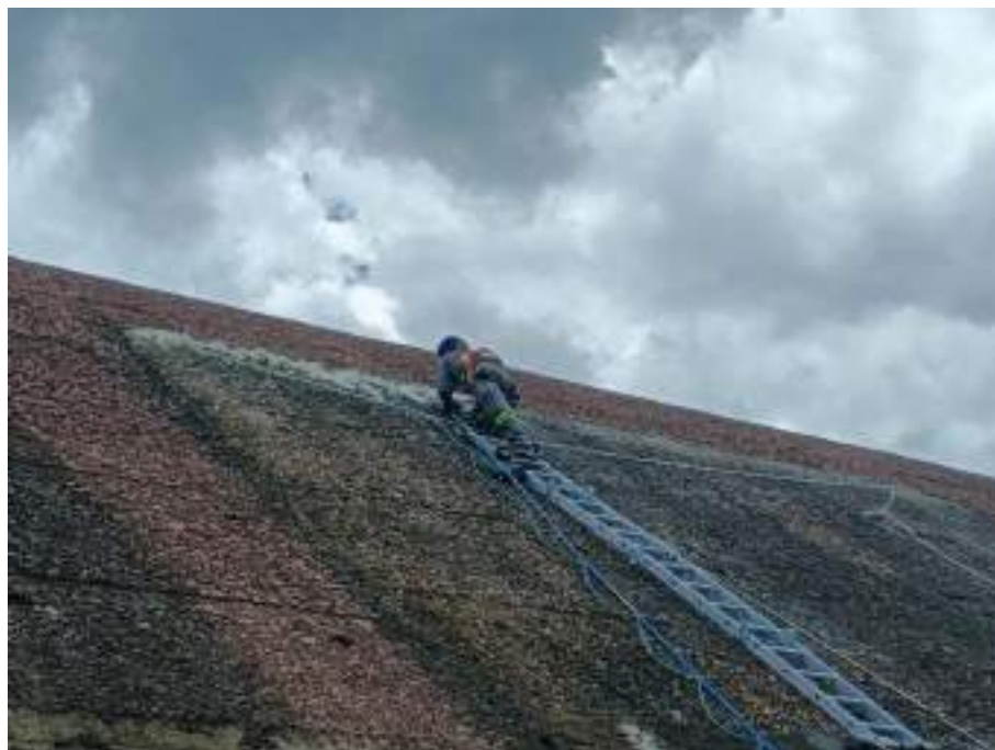
Figura 121 – Injeção de poliuretano na VAC 04.
