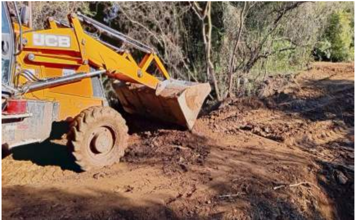
Figura 60 – Atividades de reparo.
