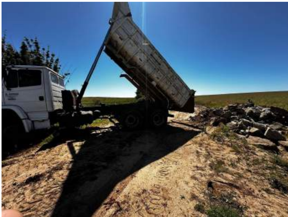
Figura 64 – Atividades de reparo.
