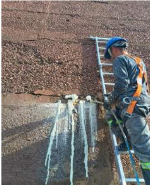
Figura 120 – Injeção de poliuretano na VAC 04.
