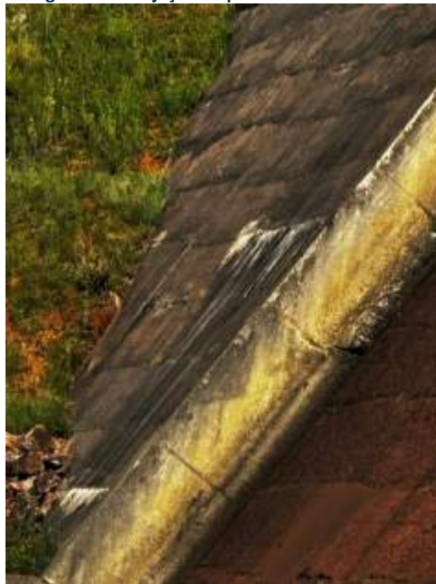
Figura 133 – Injeção de poliuretano na VAC 04.
