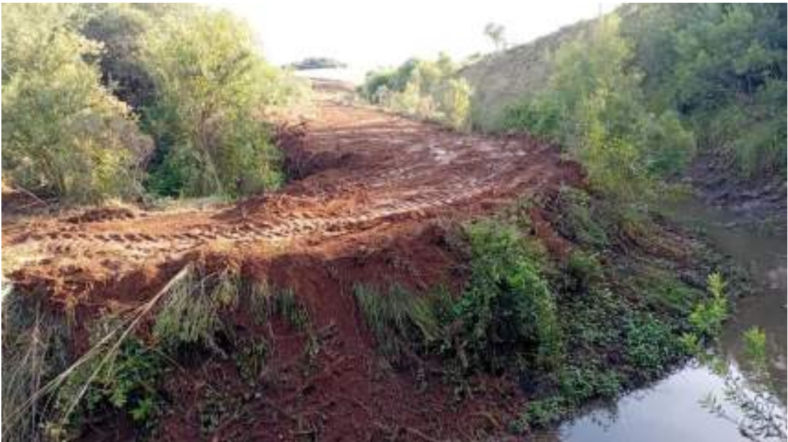
Figura 27 – Atividade de reconstrução do aterro no Canal VAC 04.
