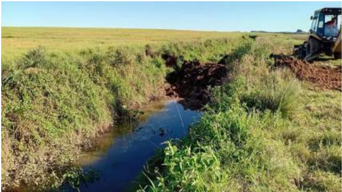
Figura 69 – Atividades de reparo.
