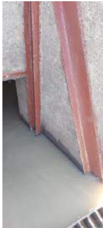
Figura 143 – Manutenção no sistema VAC 06.
