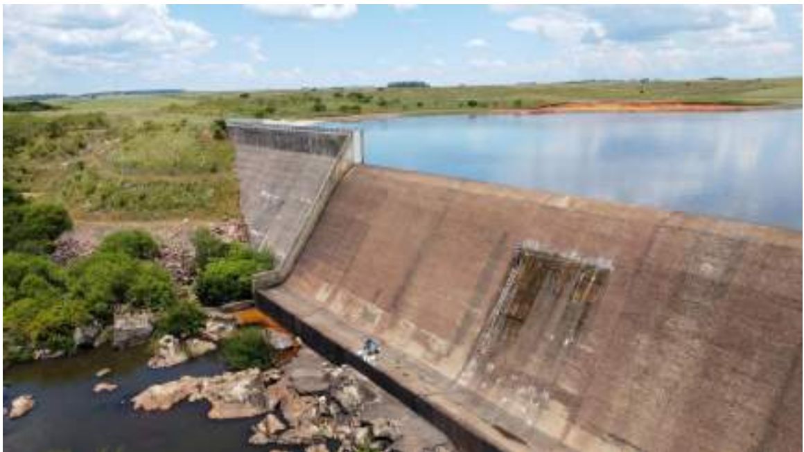
Figura 129 – Injeção de poliuretano na VAC 04.
