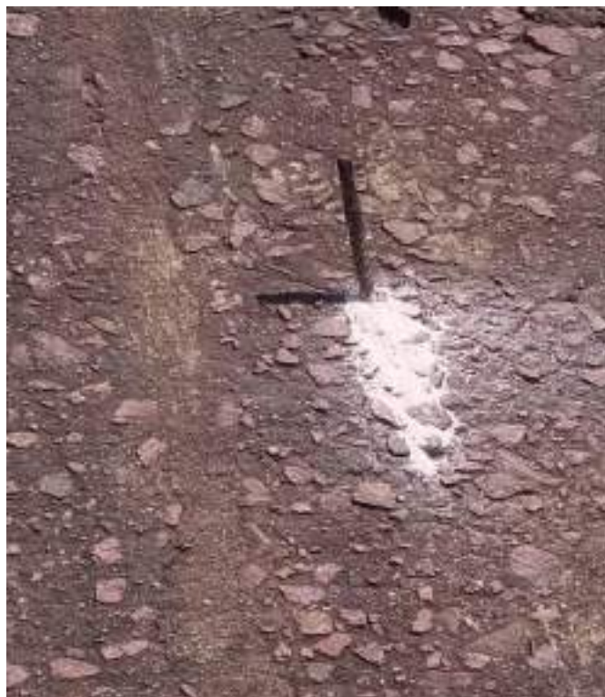
Figura 127 – Injeção de poliuretano na VAC 04.
