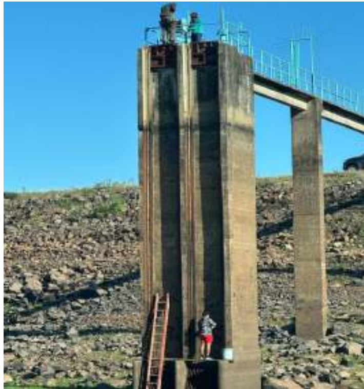
Figura 140 – Manutenção no sistema VAC 06.
