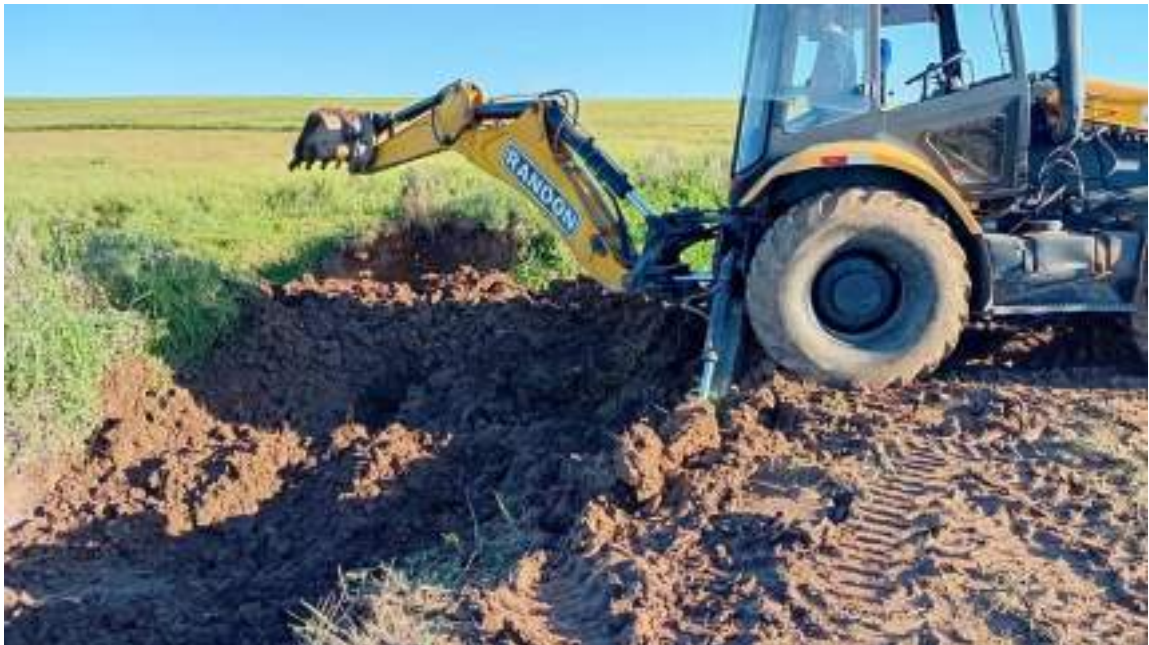
Figura 67 – Atividades de reparo.
