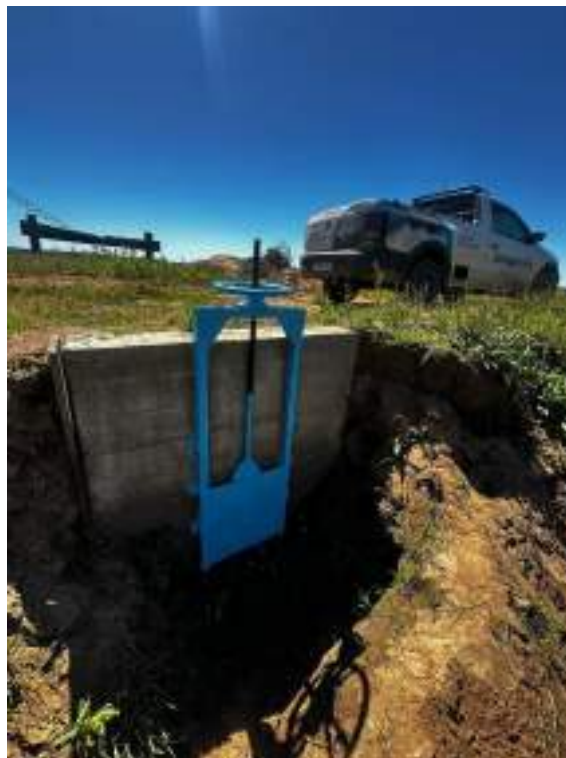
Figura 152 – Atividade de manutenção.
