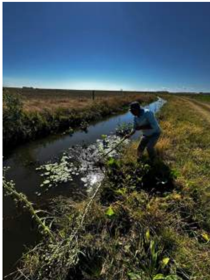
Figura 160 – Atividades de manutenção.
