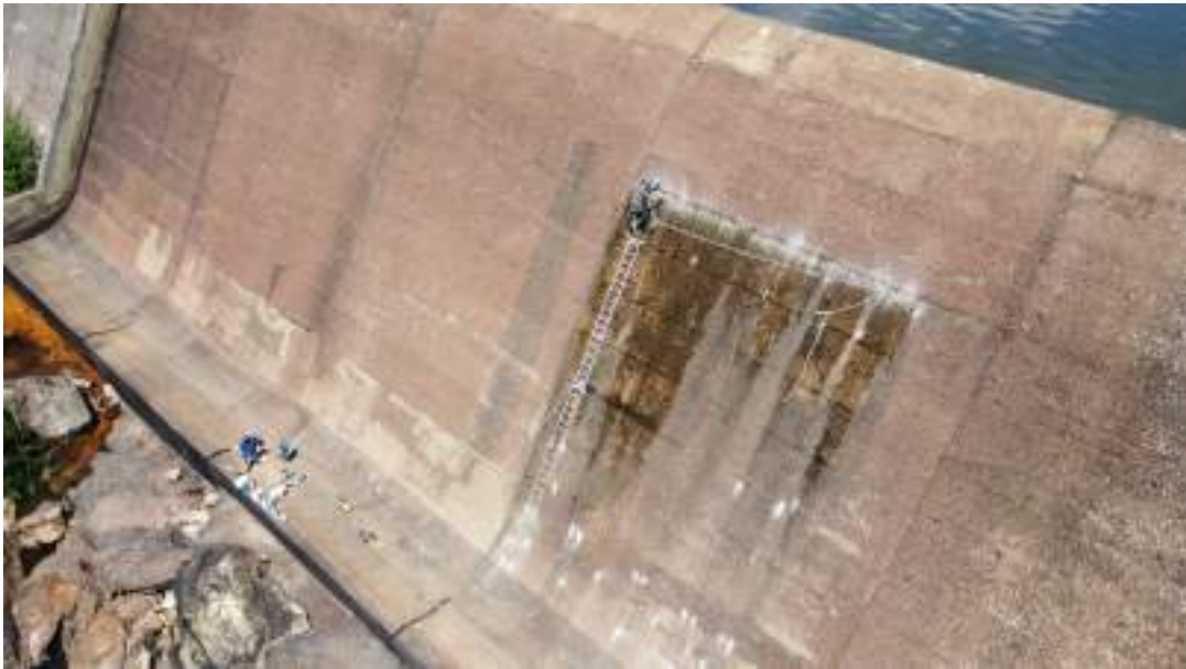
Figura 128 – Injeção de poliuretano na VAC 04.
