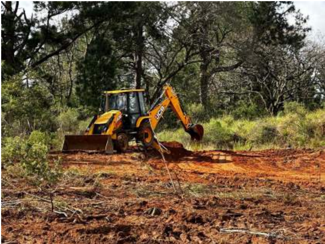
Figura 26 – Atividade de reconstrução do aterro no Canal VAC 04.
