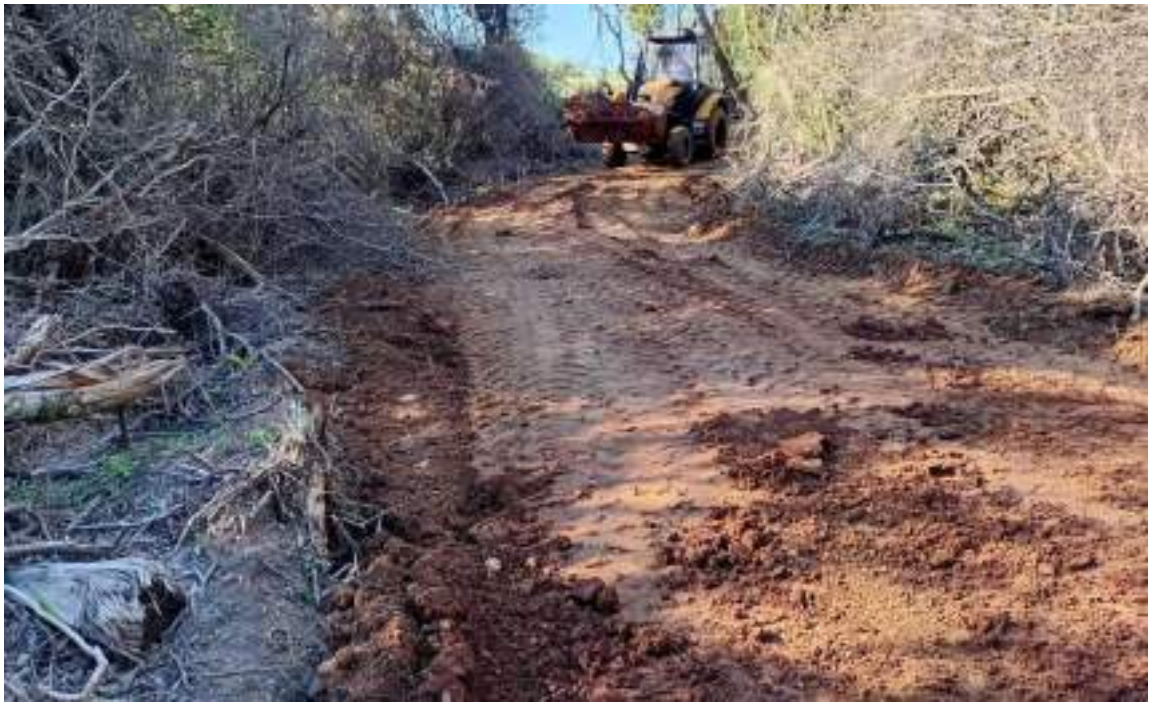
Figura 58 – Atividades de reparo.
