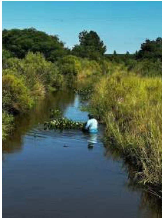
Figura 186 – Atividade de manutenção.
