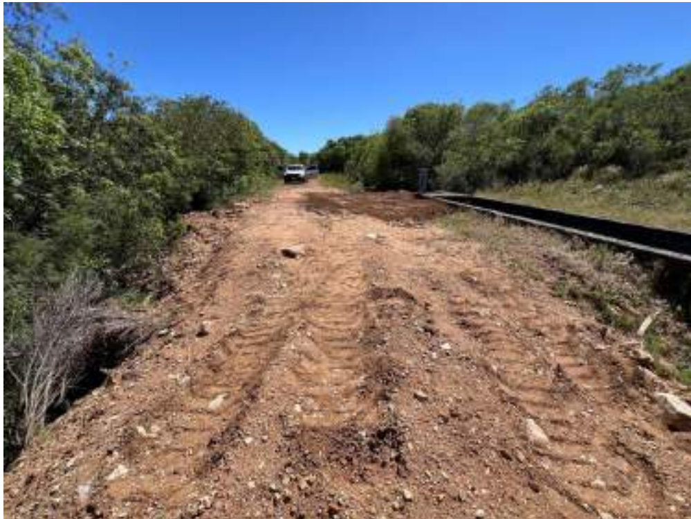
Figura 118 - Atividade de reparo no Canal VAC 04.
