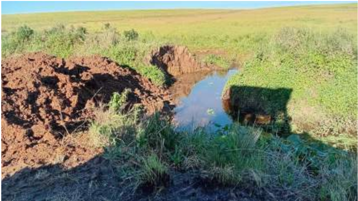
Figura 68 – Atividades de reparo.
