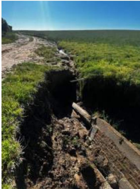
Figura 62 – Atividades de reparo.
