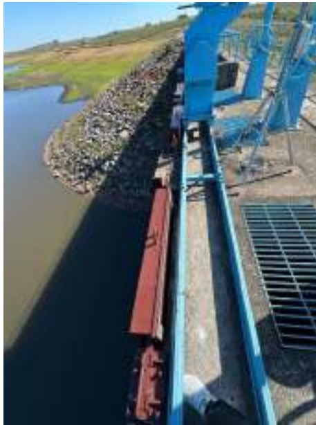
Figura 138 – Manutenção no sistema VAC 04.
