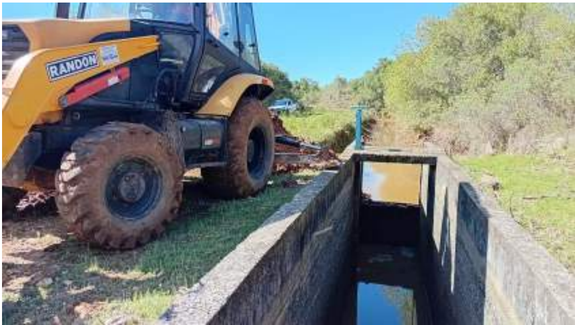
Figura 115 - Atividade de reparo no Canal VAC 04.
