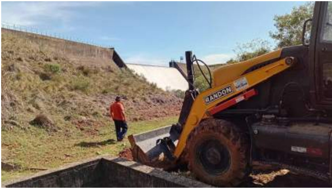
Figura 54 – Atividades de reparo.
