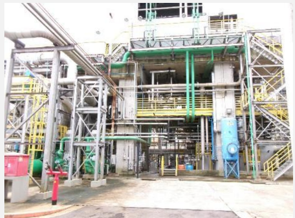
Prédio da turbina a vapor UG2.
