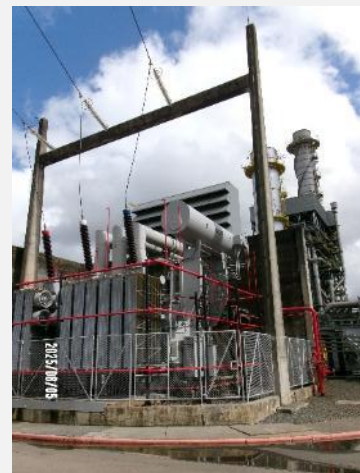
Torre de resfriamento do condensador.
