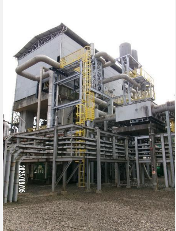
Prédio da turbina a vapor UG2.
