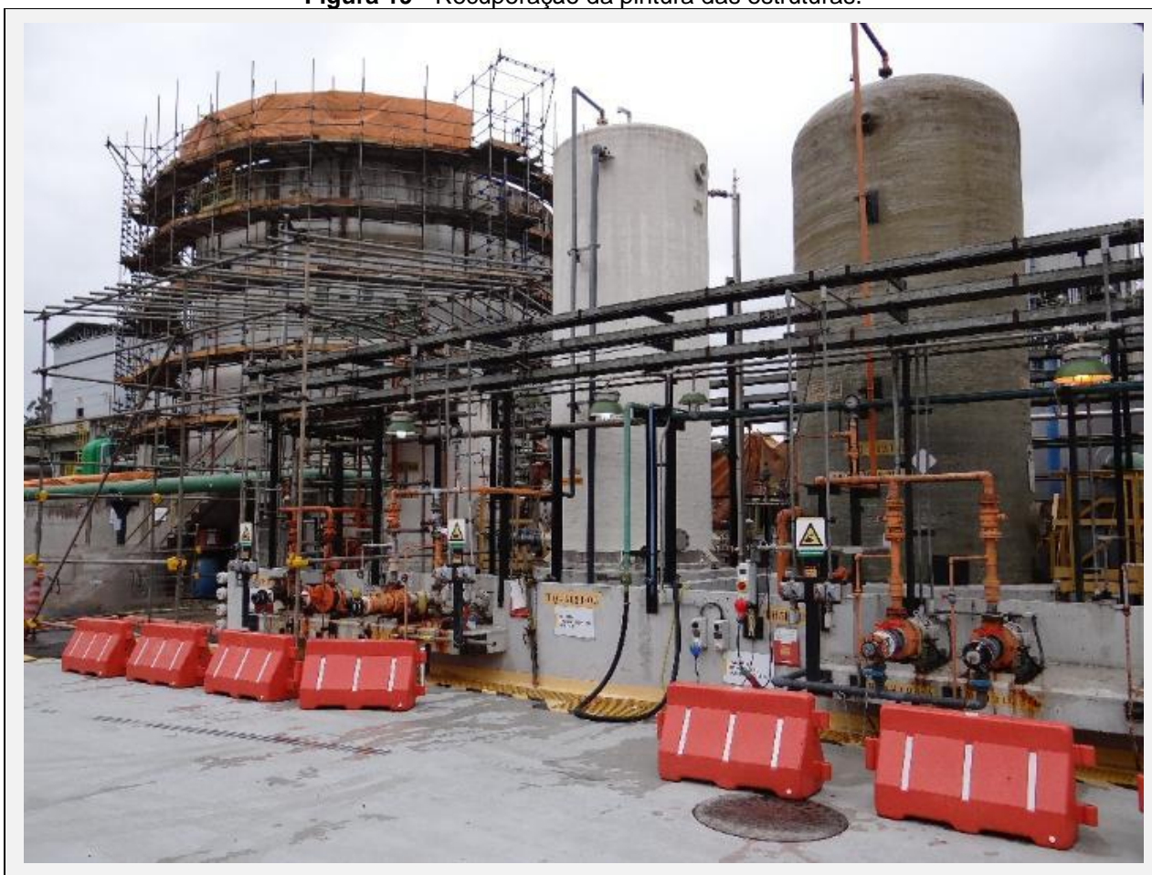
Figura 19 - Recuperação da pintura das estruturas.
