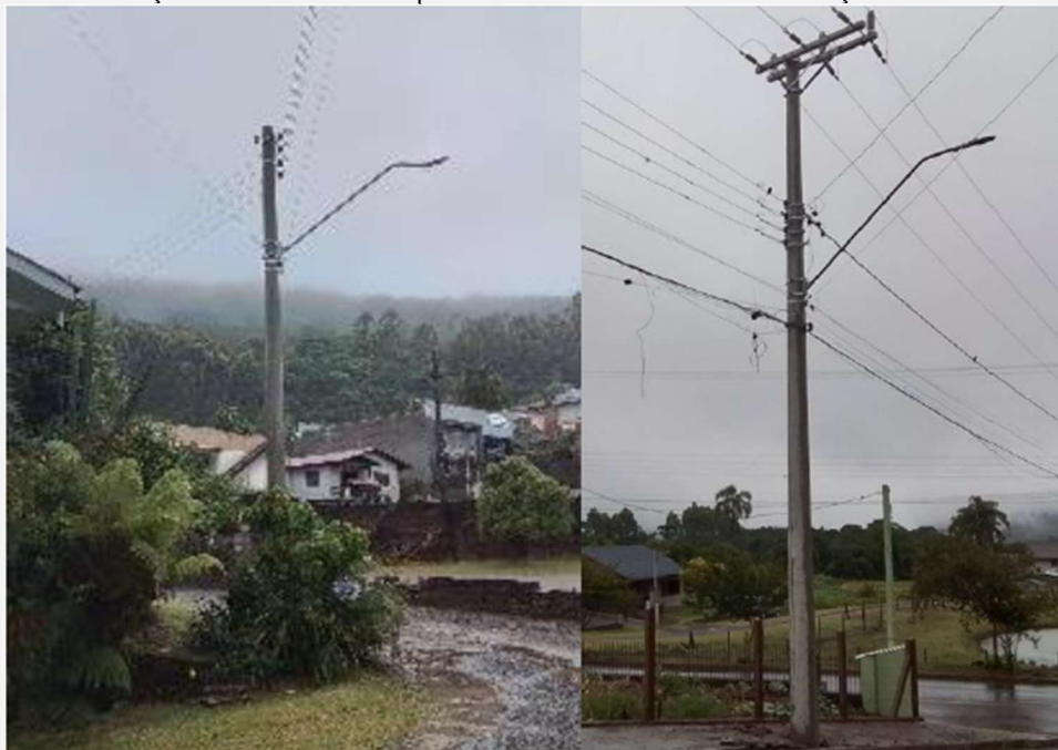
Serviço realizado no município de Morro Reuter - Nota de Serviço 6472041.
