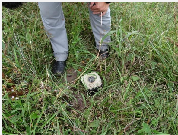
Marco superficial 10 para monitoramento do talude da margem esquerda da barragem do Salto.
