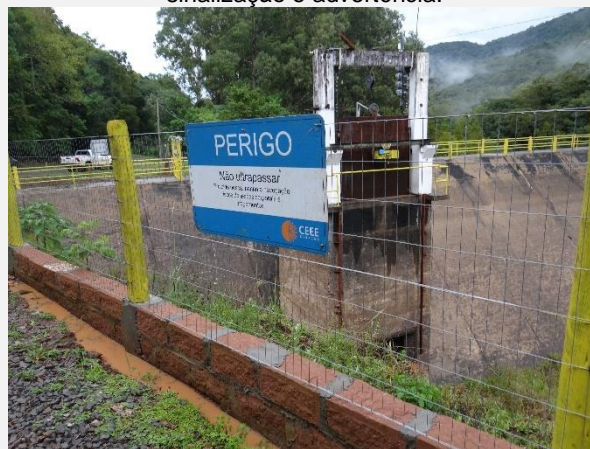
Recomposição de cercas perimetrais e de placas de sinalização e advertência.
