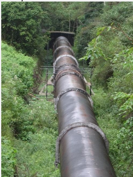
Conduto adutor da UHE Canastra submetido a substituição de troca de elementos vedantes.
