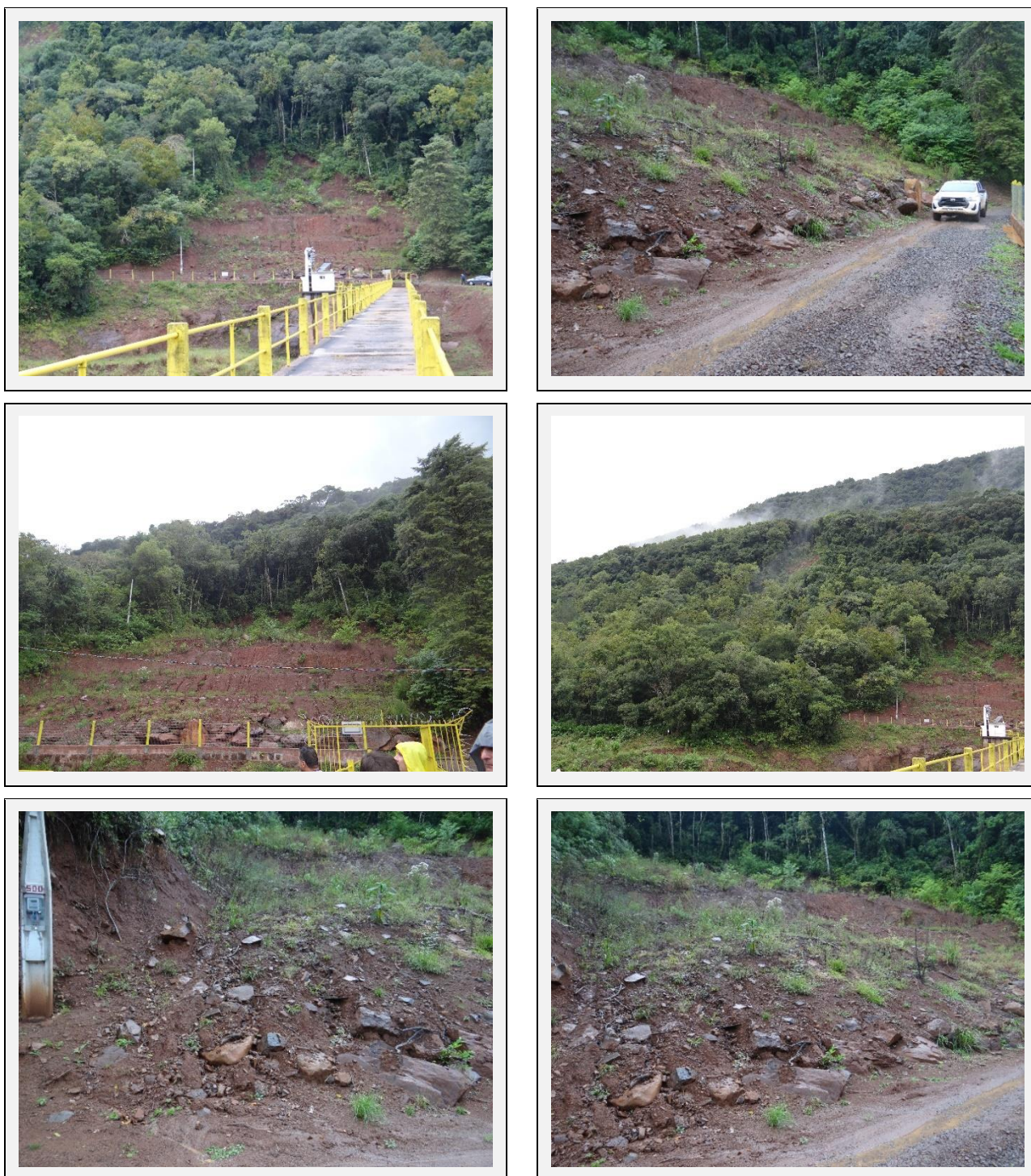
Figura 17 - Registro fotográfico realizado em 7 de abril de 2026 no talude da margem esquerda da barragem da UHE Canastra.
