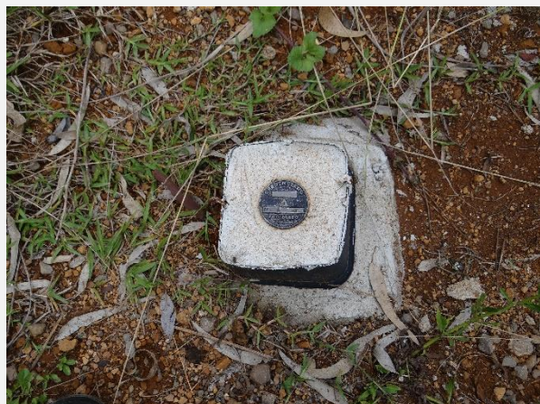
Marco superficial 4 instalado para monitoramento do talude da margem esquerda da barragem do Salto.
