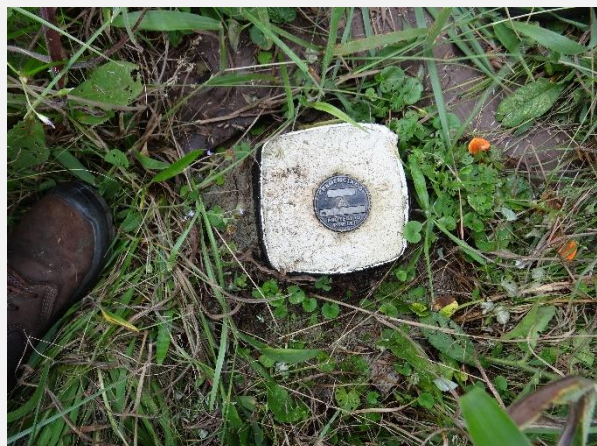
Marco superficial 10 instalado para monitoramento do talude da margem esquerda da barragem do Salto.
