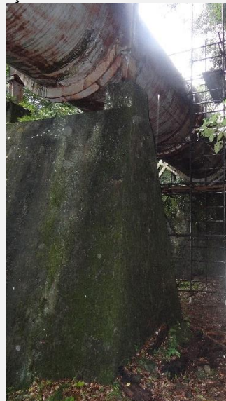
Conduto adutor da UHE Canastra submetido a substituição de troca de elementos vedantes.
