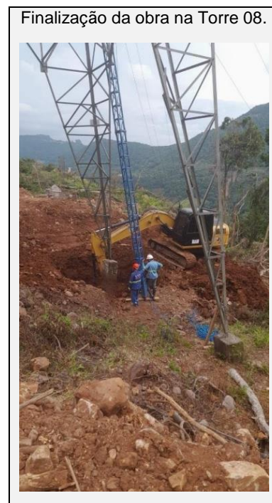
Figura 28 - Reparação da sapata da Torre 08 - Recuperação da LT de 230 kV da UHQJ.
