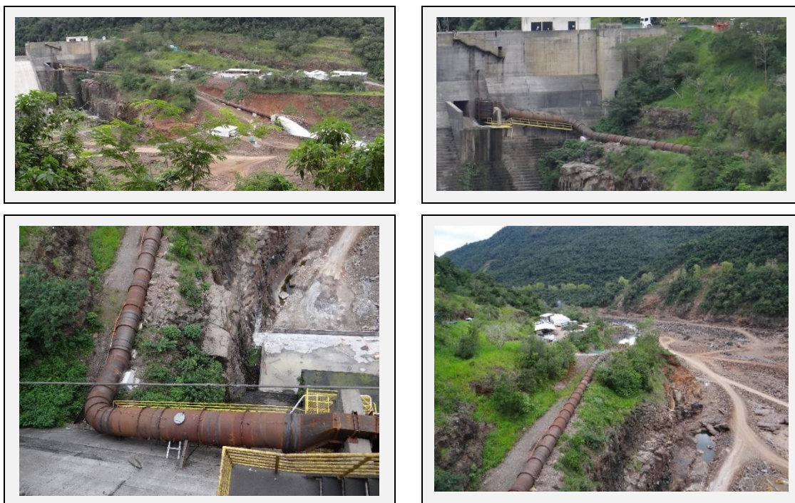
Figura 11 - Conduto forçado, usina de concreto, laboratório de concreto e sistema de alerta na UHE Castro Alves.
