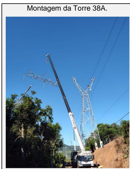
Figura 29 - Torre 38A - Recuperação da LT de 230 kV da UHQJ.
