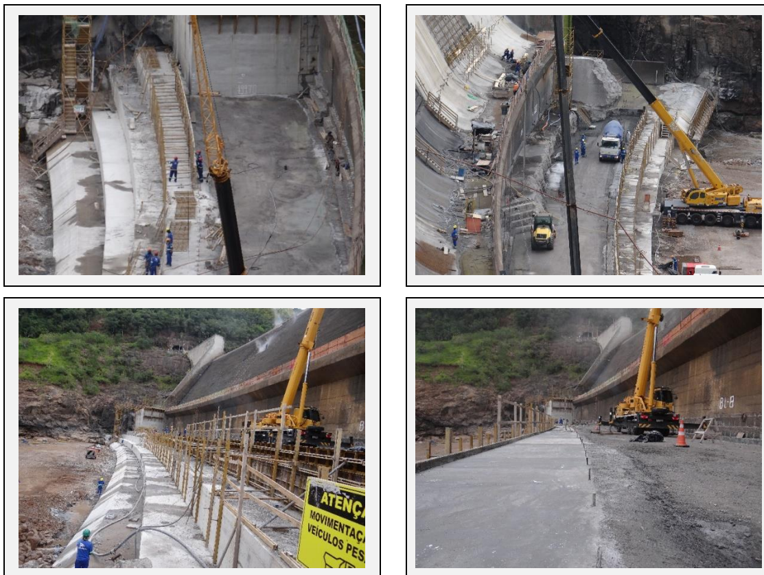
Figura 6 - Obras no pé da barragem de UHE Castro Alves.
