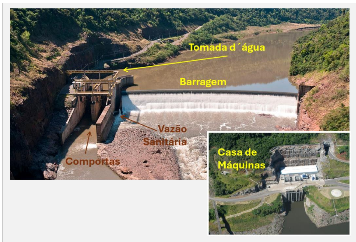
Figura 4 - Arranjo geral da UHE Monte Claro.
