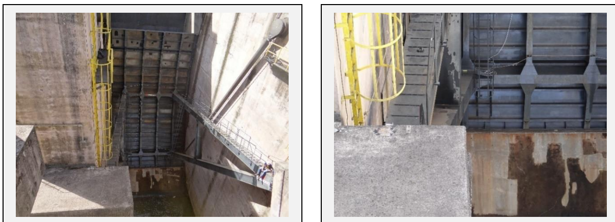
Figura 23 - Registro fotográfico da conclusão das atividades de recuperação da comporta segmento do vertedouro na UHE Monte Claro, inspeção de campo em 15/04/2026.
