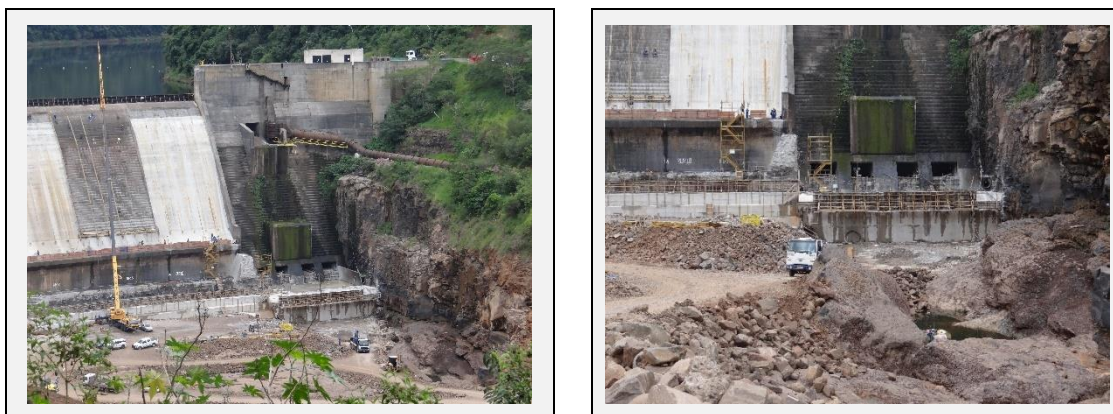
Figura 7 - Obras nas adufas da UHE Castro Alves.
