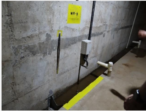
Medidor de vazão ultrassônico na galeria de drenagem.
