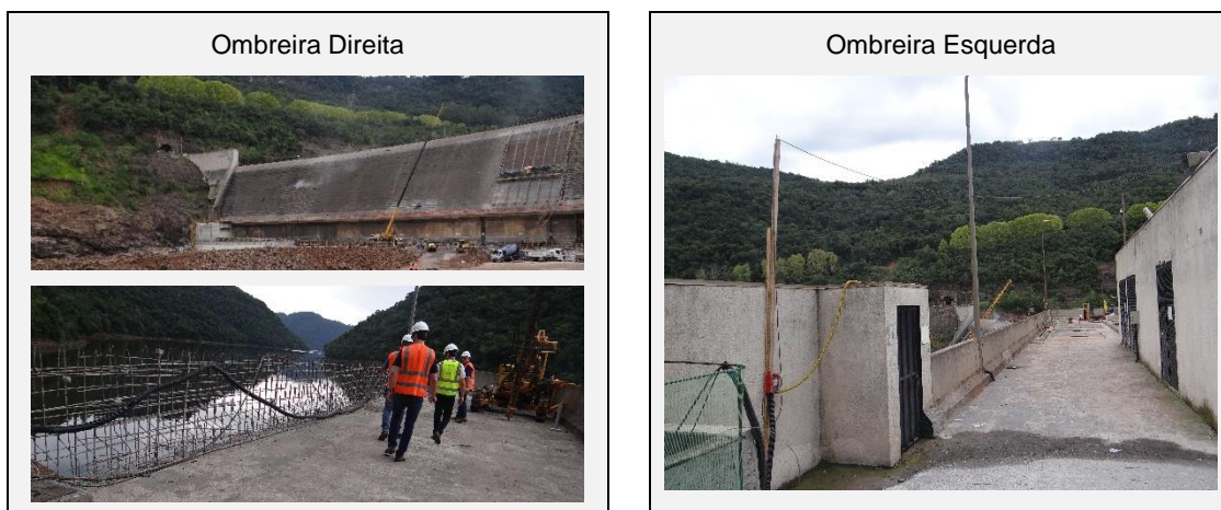
Figura 8 - Obras nas ombreiras da UHE Castro Alves.
