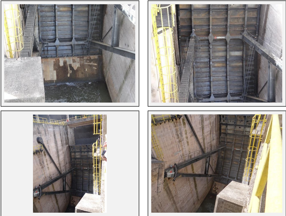
Figura 24 (cont.) - Registro fotográfico da conclusão das atividades de recuperação da comporta segmento do vertedouro na UHE Monte Claro, inspeção de campo em 15/04/2026.
