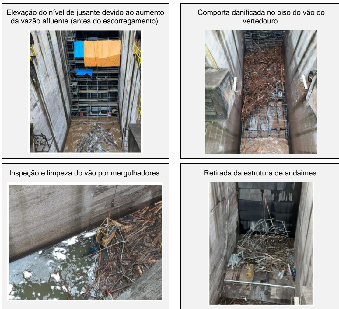
Figura 21 - Registros fotográficos da ocorrência durante a montagem da comporta segmento 01 do vertedouro da UHE Monte Claro - Carta CERAN nº 037/2025.
