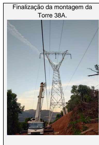
Figura 29 - Torre 38A - Recuperação da LT de 230 kV da UHQJ.
