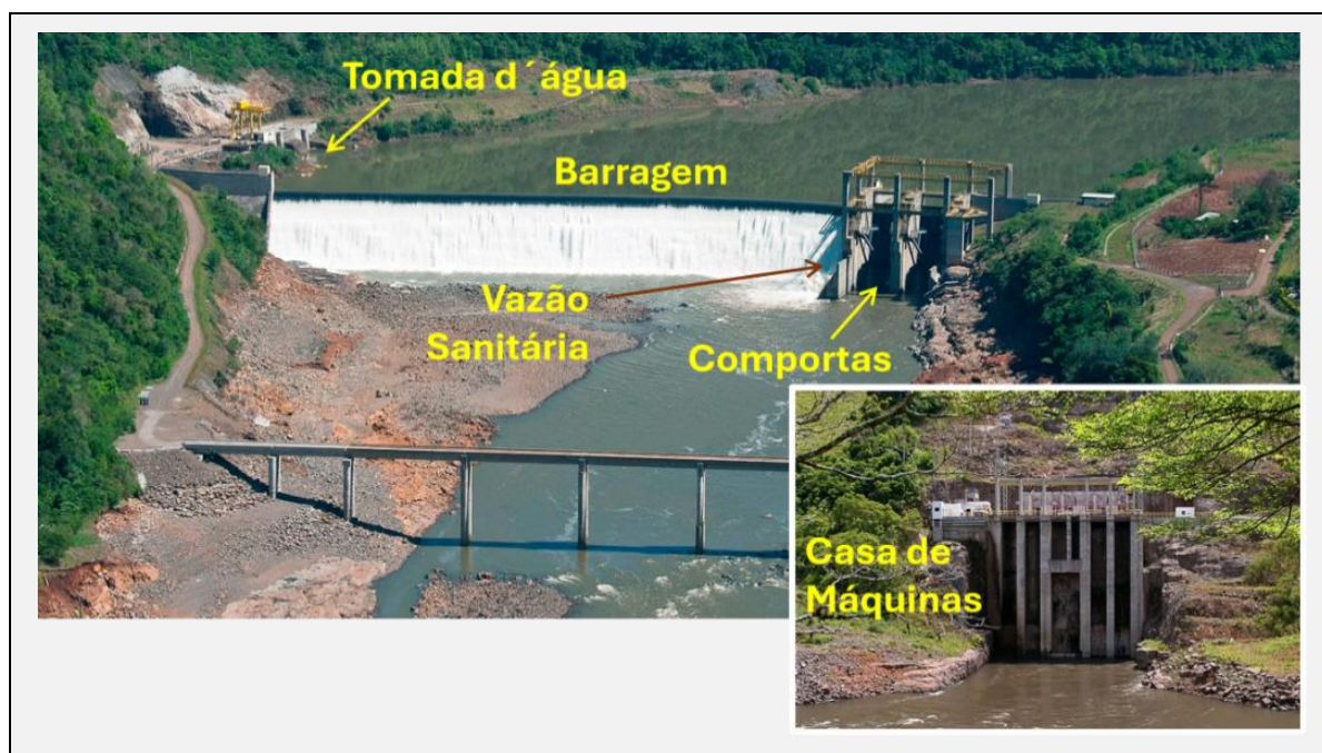
Figura 5 - Arranjo geral da UHE 14 de Julho.
