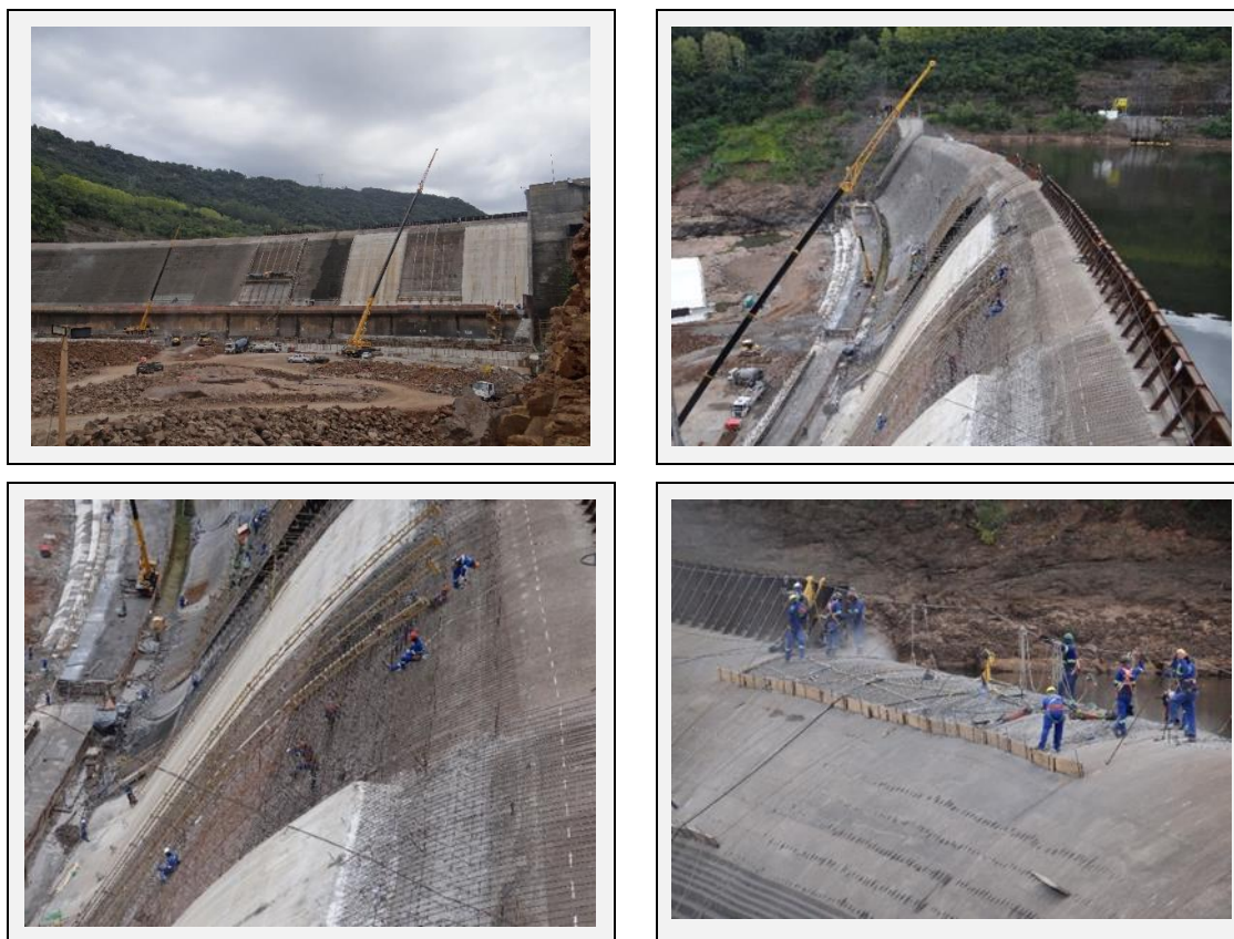
Figura 9 - Obras no vertedouro da UHE Castro Alves.
