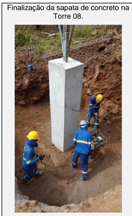
Figura 28 - Reparação da sapata da Torre 08 - Recuperação da LT de 230 kV da UHQJ.
