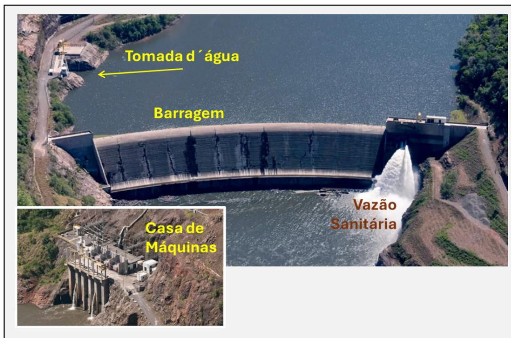
Figura 2 - Arranjo geral da UHE Castro Alves.
