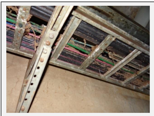
Figura 37 - Presença de lama, detritos e pequena vegetação sobre cabos de média tensão em prateleiras metálicas da galeria de drenagem.
