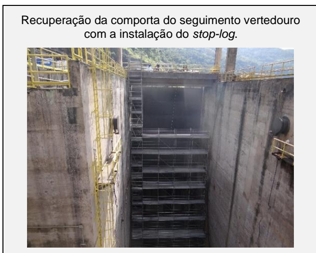
Figura 19 - Registro fotográfico das ações em andamento referentes a manutenção da comporta do seguimento vertedouro na UHE Monte Claro.
