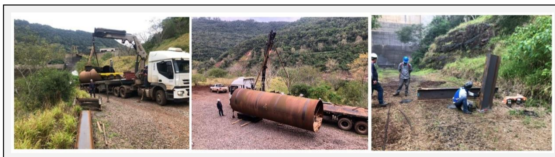
Figura 15 - Registro fotográfico da mobilização do conduto metálico e a instalação das bases.
