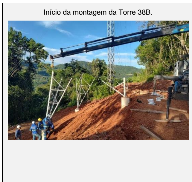
Figura 30 - Torre 38B - Recuperação da LT de 230 kV da UHQJ.
