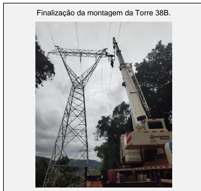
Figura 30 - Torre 38B - Recuperação da LT de 230 kV da UHQJ.
