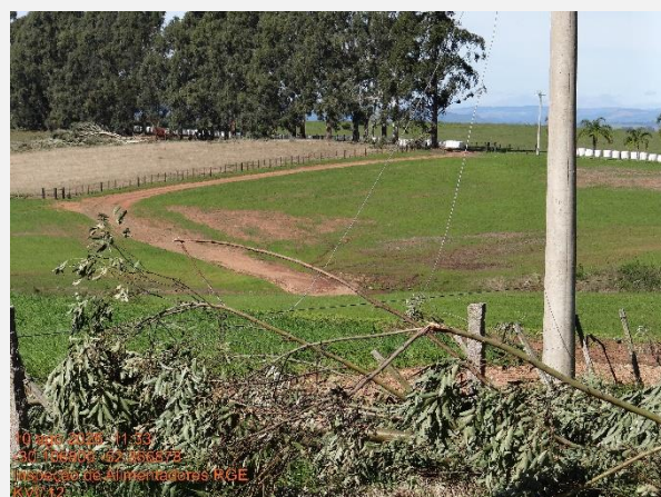
Cabos do alimentador partidos tocando o solo.
