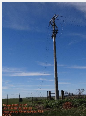
Cabos do alimentador partidos tocando o solo.
